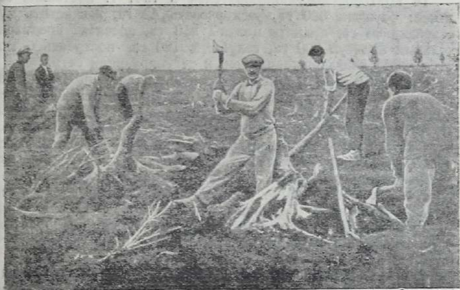
На фото: ручная корчевка пня на участке „Сасова болото“.
